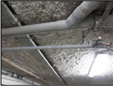
Photo N° 584 ECH-N°1 FLOCAGE -- PARKING Plafonds BLANC COTONNEUX
